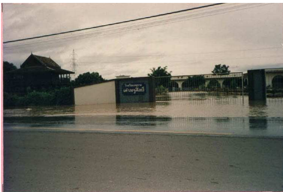
ถนนเชียงใหม่ - สันกำแพง ได้รับอิทธิพลจากน้ำแม่กวัง 26 ส.ค. 30
